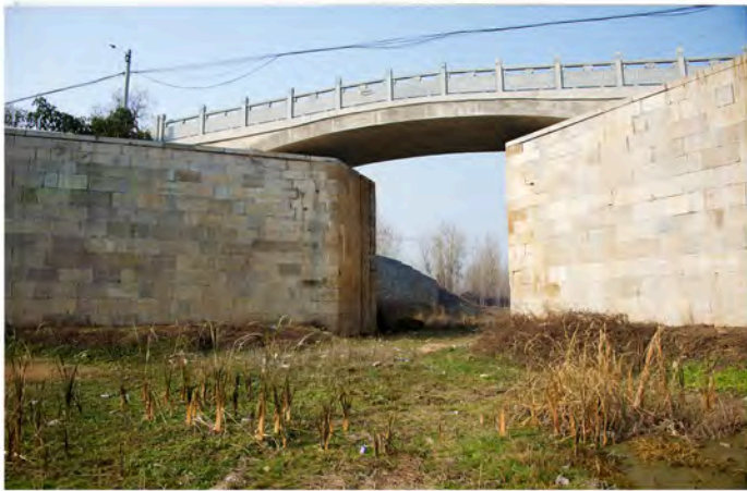
图 3 南旺第一牐——柳林闸，修复后闸上设桥供村民使用
