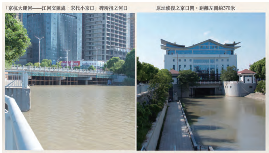
图 58 京口闸及大运河、长江交汇口之现在面貌
