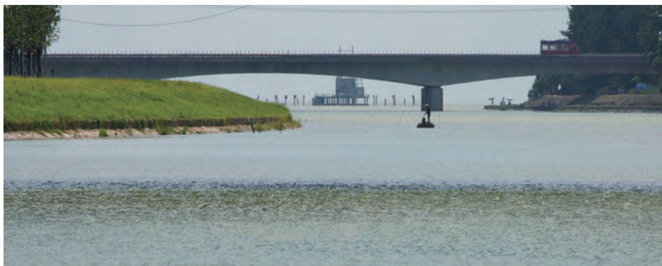
图 29 跨望虞河之沙墩港桥 (31°27'4.908"N, 120°25'7.47"E, 自望亭水利枢纽拍摄, 外即太湖)
