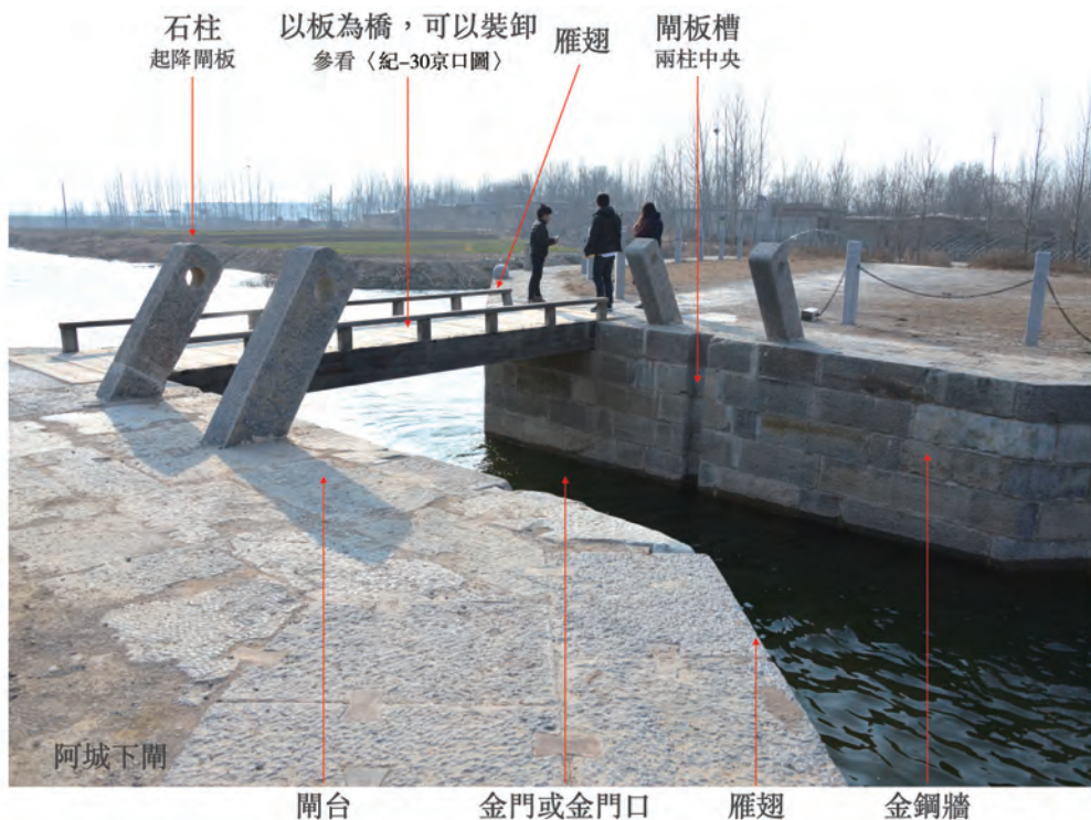
图 42 修复后之阿城下閘(閘槽及石柱结构都如古制)
