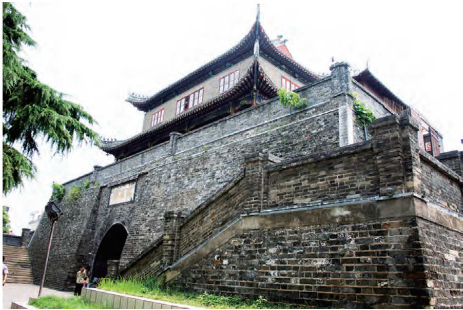
图70 镇淮楼北面(南向为正面,北向为内部,从此角度看,登楼结构更清楚)
