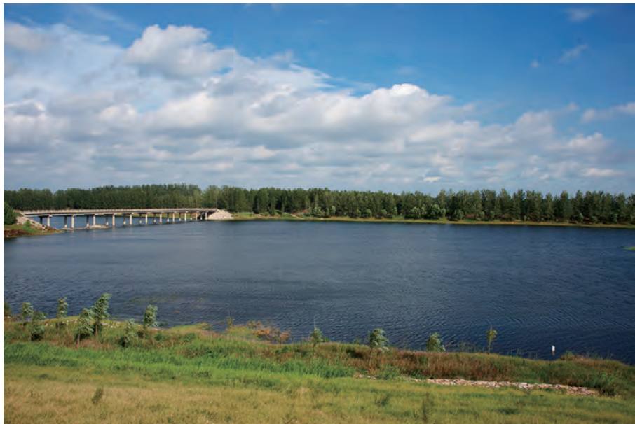
图 123 张秋镇一侧的金堤河(拍摄点为 36°3'33.7"N,116°0'21.82"E)
