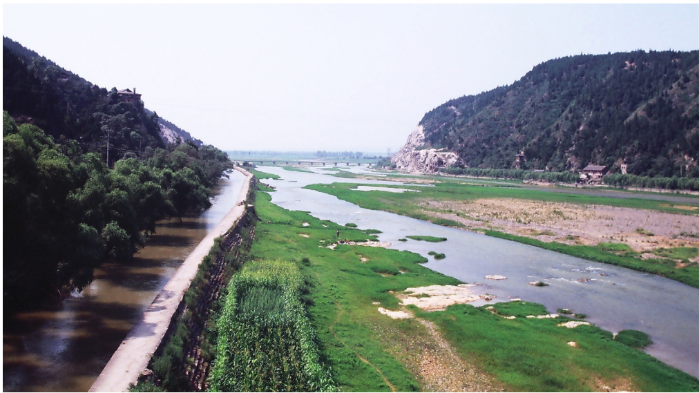
图 8 图左的沟渠便是伊东渠, 在龙门伊水的东岸上流过, 此为笔者 1989 年拍摄
