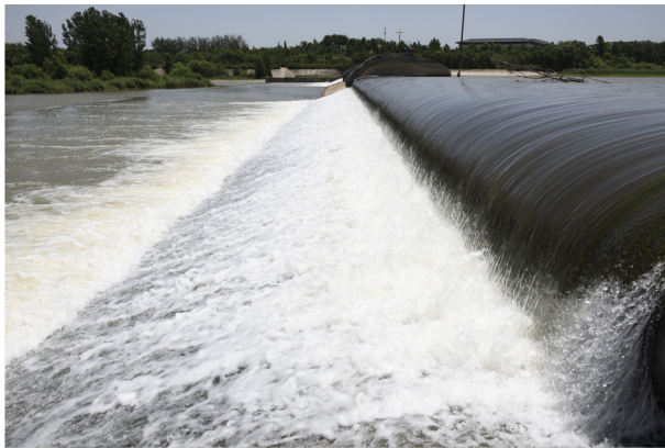
图 6 伊水新坝（橡皮坝），在坝体北端拍摄 34°36'59.54"北, 112°30'27.99"东
